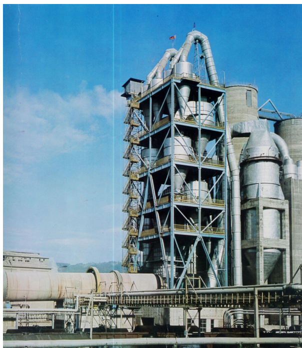
Fig. 5.4. Instalație pentru obținerea cimentului
